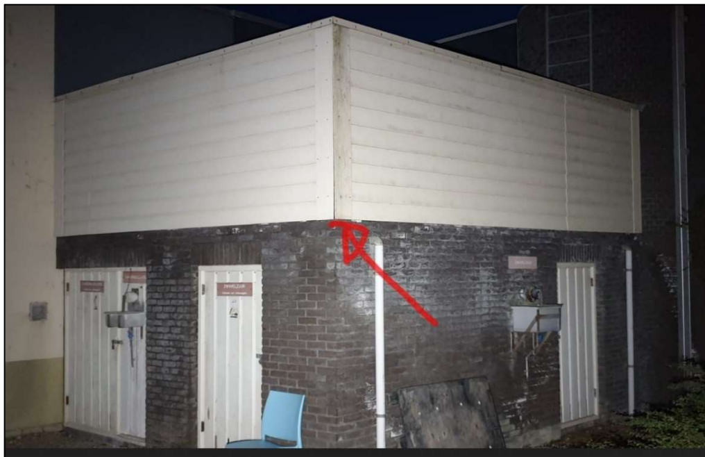
Figuur 4.8. Verblijfplaats van de gewone dwergvleermuis bij het gebouw zwembad.
