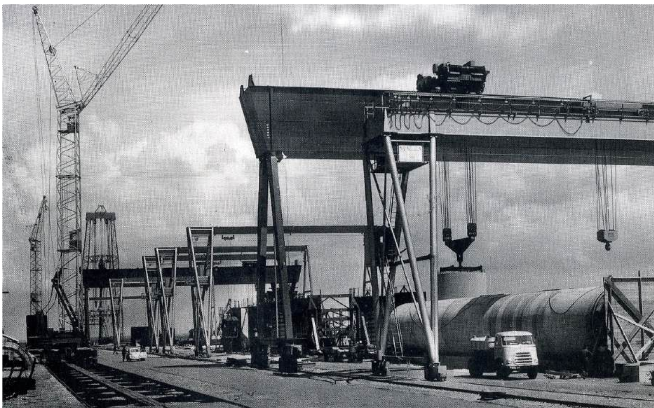
Figuur 2.2 Bouw van de Zeelandbrug in de haven van Kats
