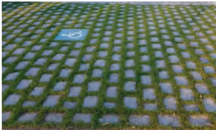
Parkeren op 'groene' verharding, kasseien met ruimte voor gras ertussen
