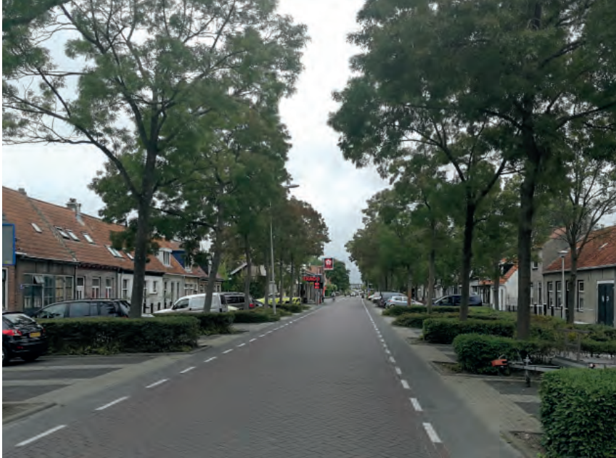
Gesloten bebouwing 1 laag met kap, brede rijbaan in klinkers
